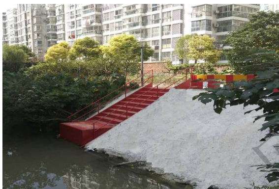
图 4 可设置机动消防泵的取水平台实例
